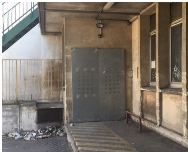
Les panneaux renforcés ultra sécurisés ont été installés sur toutes les ouvertures du rez-de-chaussée
